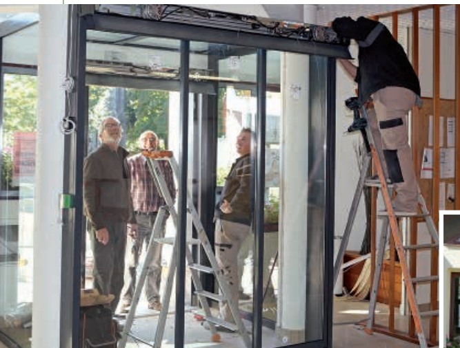
Installation de la porte automatique
