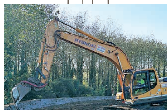
Chantier de talutage
